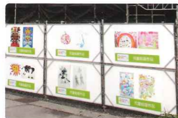
こどもたちのイラスト入りの工事仮囲い
