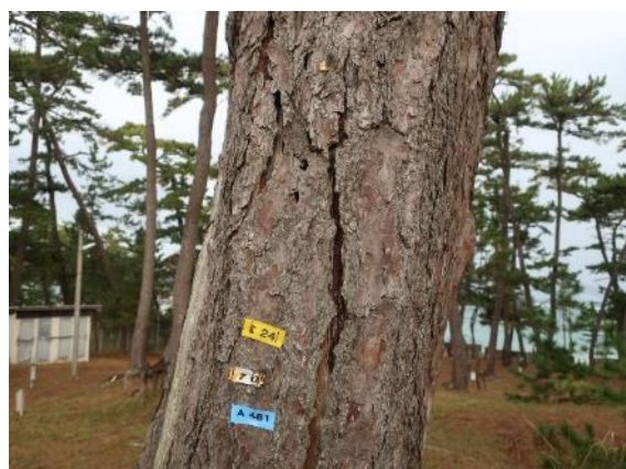
幹にみられる亀裂（拡大）
