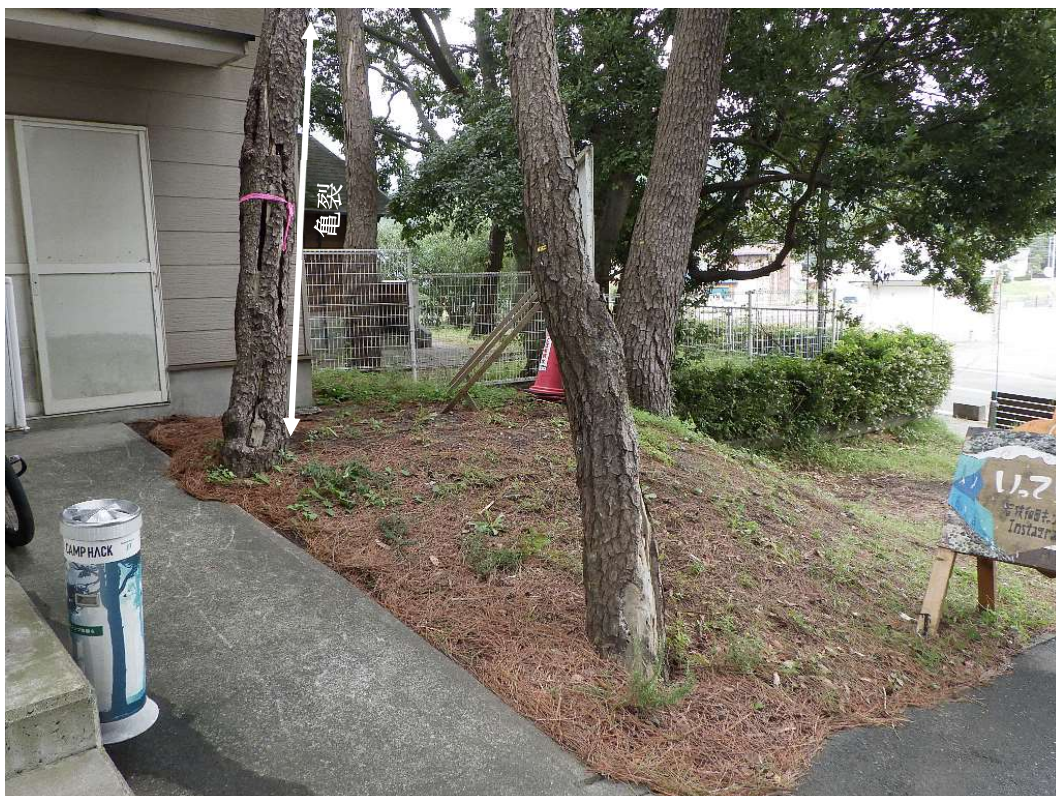
建築物等に接して生える個体に亀裂が入っている例
