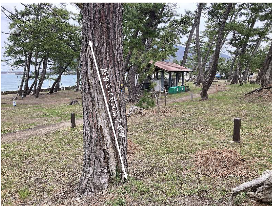
根元に腐食が入っていることが伺える亀裂の例
