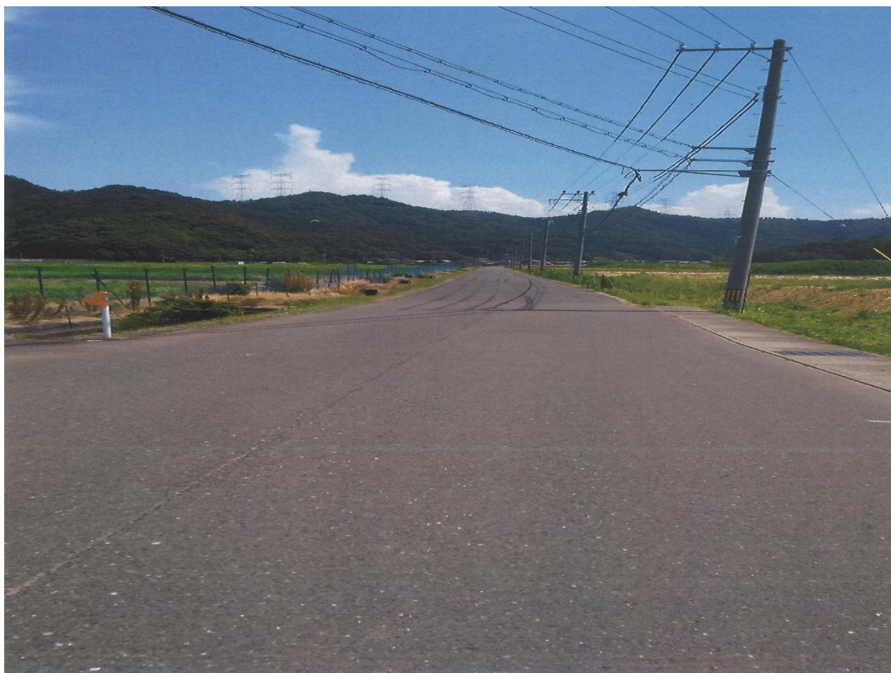
和田小学校 No.6 車持へ向かう道路
