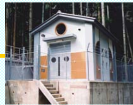
▲鎌倉簡易水道一膜処理施設 (平成14年度竣工)
