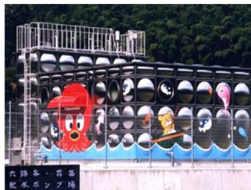
▲ 六路谷・蒜畠加圧ポンプ場
