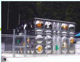
▲高野第2加圧ポンプ場 (平成17年度竣工)
