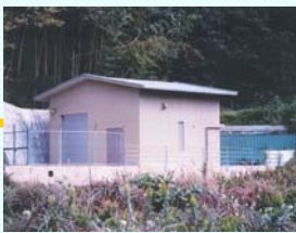
▲神野・神野浦簡易水道一膜処理施設 (平成12年度竣工)
