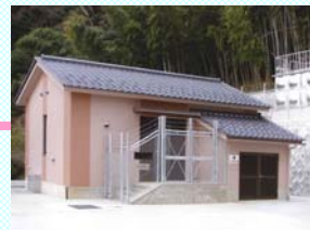
▲上瀬飲料水供給施設一膜処理施設 (平成19年度竣工)
