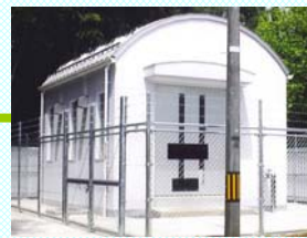
▲高野第1加圧ポンプ場 (平成17年度竣工)
