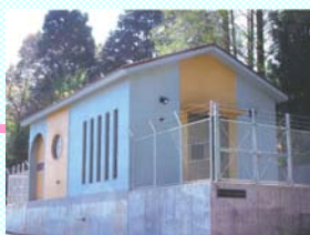
▲宮尾・下飲料水供給施設一膜処理施設 (平成15年度竣工)
