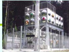
▲今寺配水池 (平成17年度竣工)
