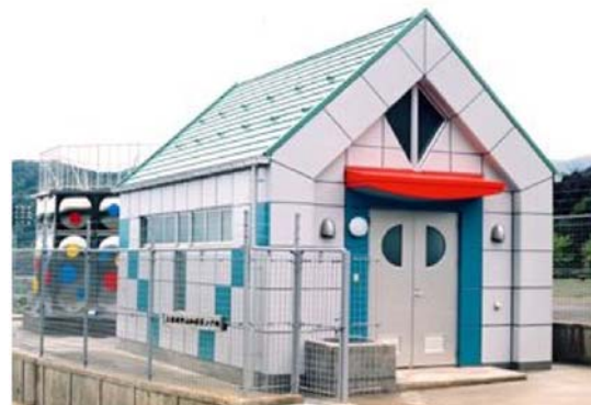
▲ 中山加圧ポンプ場
