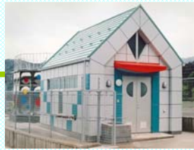
▲中山加圧ポンプ場 (平成14年度竣工)
