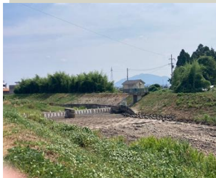
8月 関屋川状況
