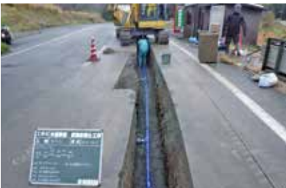
◆実施箇所 配水管耐震化 高野地係…1式
