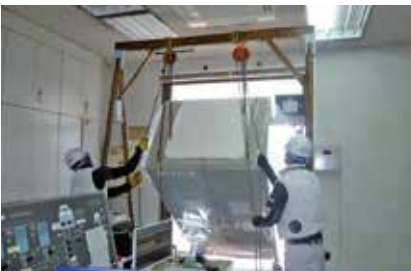
◆実施箇所 東三松地係(上水道センター) …1式
