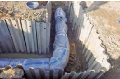
◆実施箇所 配水管布設 宮崎地係…1式
