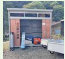
防災資機材購入
