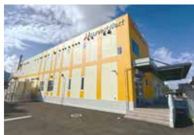
給食センター外観
