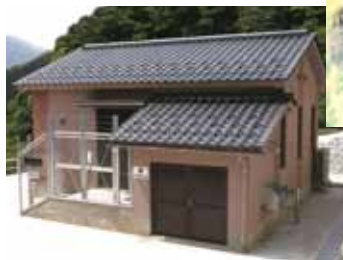
上瀬飲料水供給施設
