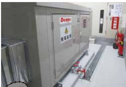
非常用自家発電機
