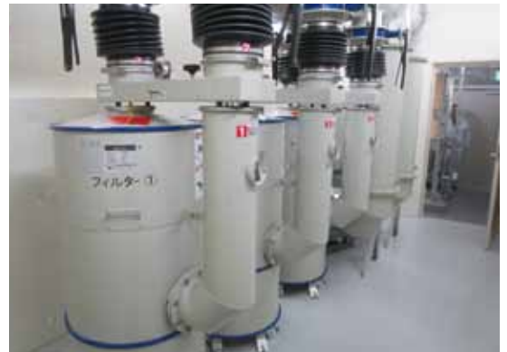
空気浄化フィルター設備
