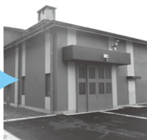
浄化センター(新施設)
