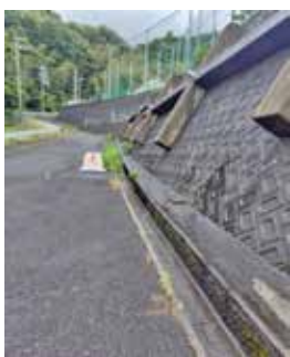
中央球場横の側溝
