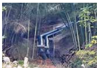
耐震化された送水管・配水管（配水池まで未接続）
