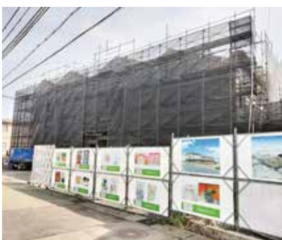
建設中の(仮称)高浜町社会福祉施設
