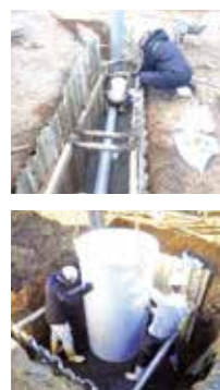
下水道管工事
