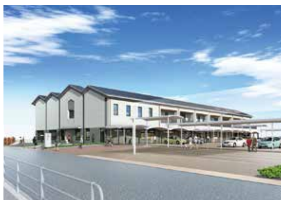
建設中の(仮称)高浜町社会福祉施設
