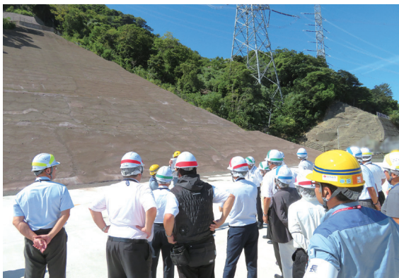
高浜発電所視察
