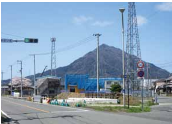
建設中の学校給食施設
