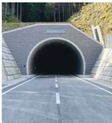
難波江トンネル
