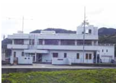
更新計画中の上水道センター
