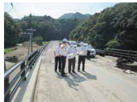
町道柿ヶ渡線新設工事
