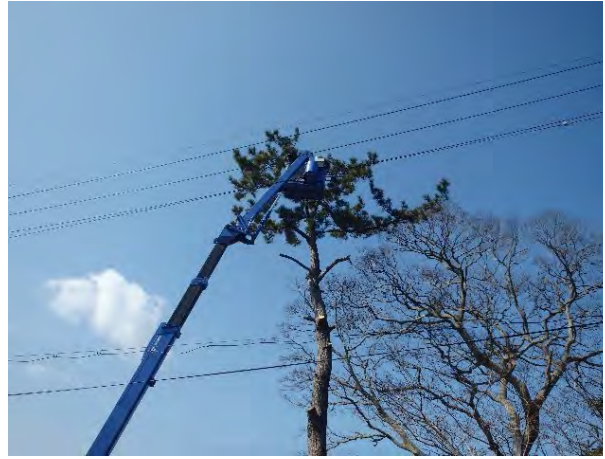
クレーンを用いた高所伐採（枝伐り）
