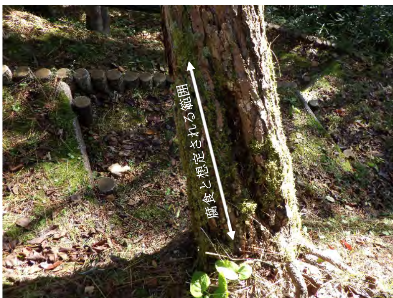
根元に腐食が入っていることが伺える例
