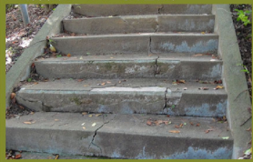
■破損している階段
