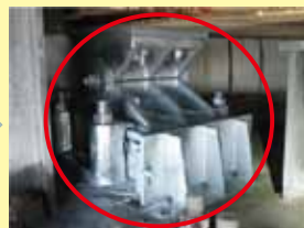
錆びにくい塗装に塗り替え、長寿命化を図る
