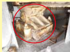
橋梁を支える支承(ししょう)が水の影響で腐食
