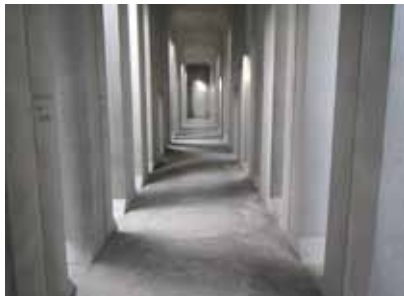
調整池の内部
