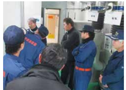
旧音海小中原子力防護施設で操作手順の確認
