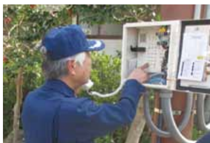
屋外スピーカーの操作確認
