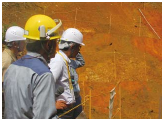
破砕帯調査のトレンチを視察し事業者の説明を受けました。
