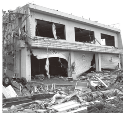
被災した陸前高田市消防本部
