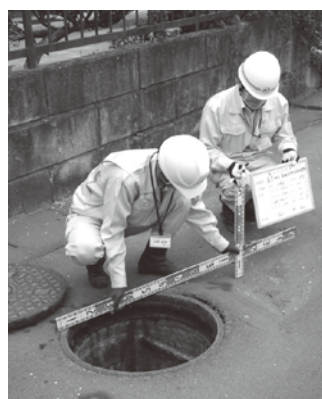
マンホールの調査
