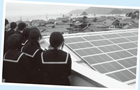
町内の小中学校に太陽光発電を設置して1年が過ぎました。昨年は猛暑で太陽光発電には厳しい環境（気温が高いと発電量が減ってしまう）でしたが、5校併せて78.9kWの発電システムから78,352kWhの発電量が得られ、電気代を削減する事ができました!!
