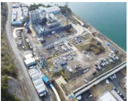
広域ごみ処理施設建設状況
