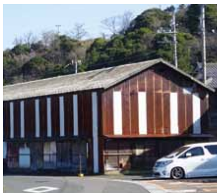
建て替え予定の和田漁具倉庫
