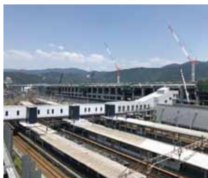
工事が進む北陸新幹線敦賀駅周辺
