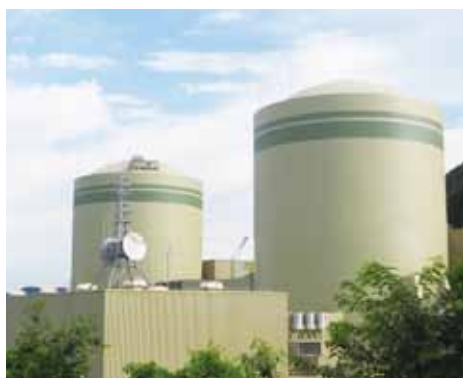
1・2号機外観写真
