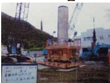
高浜町清掃センター解体の様子
