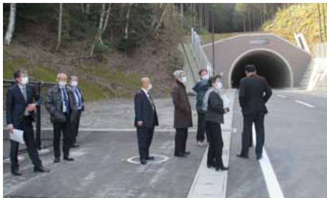
難波江坂トンネル
