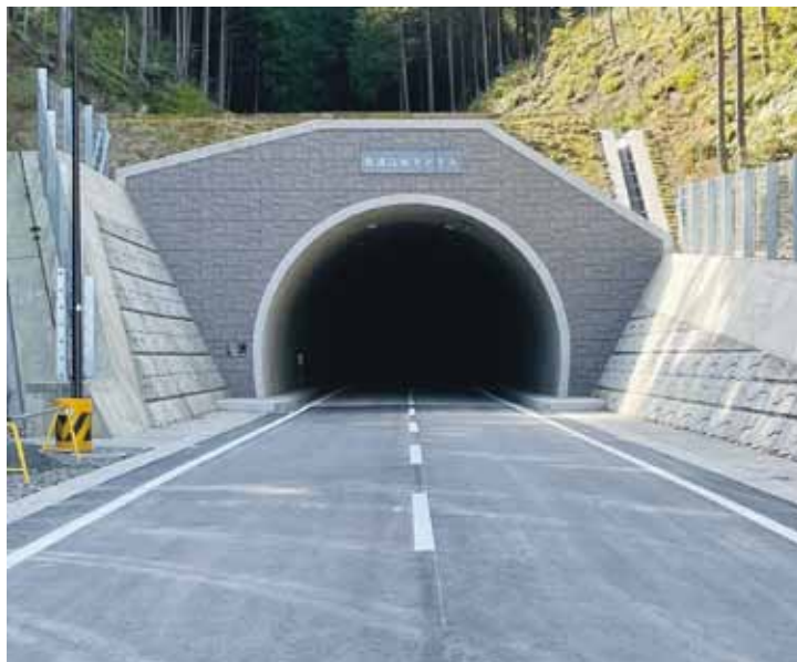
開通した難波江坂トンネル
