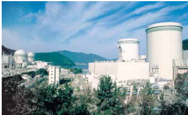
高浜原子力発電所
