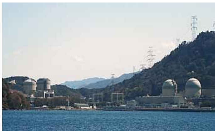
高浜原子力発電所
