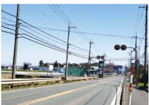
日置・青地区の歩道整備される国道27号
