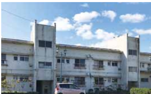
解体が決まった中町住宅
