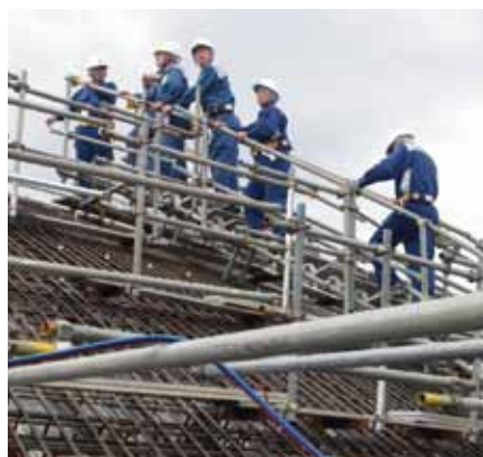
格納容器遮蔽工事現場
