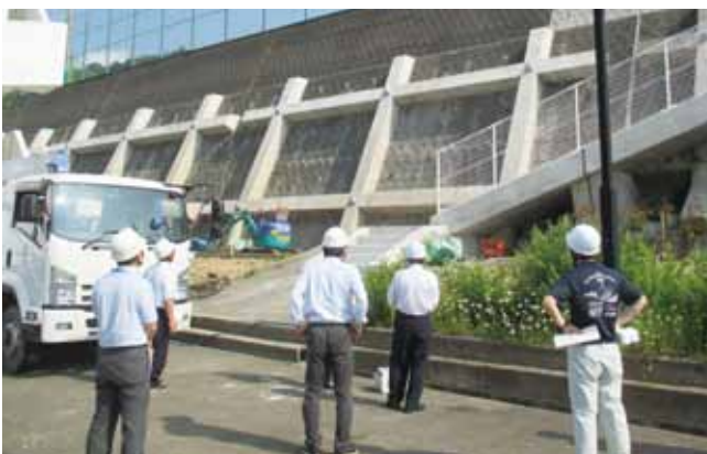
中央体育施設擁壁工事の定例監査
