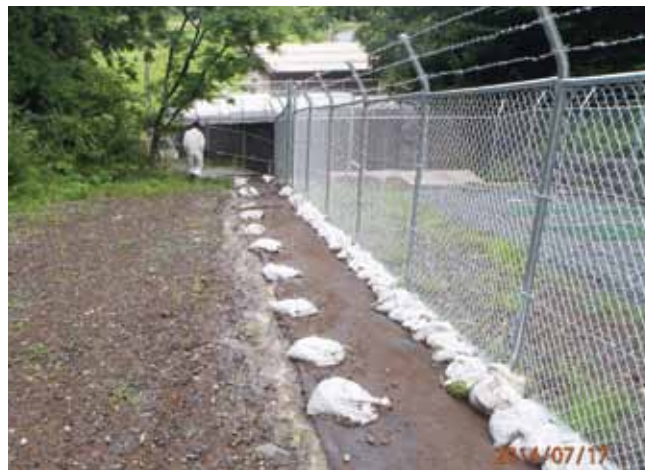
山中簡易水道施設フェンス
