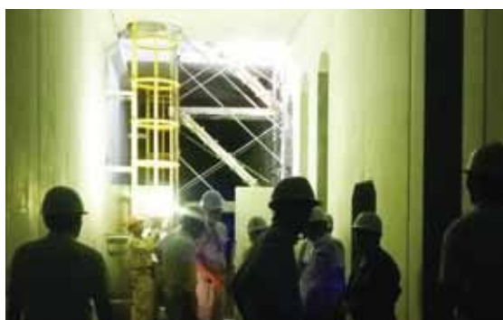
雨水調整池内部
