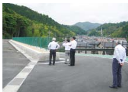
③中央体育施設擁壁改修工事現場
