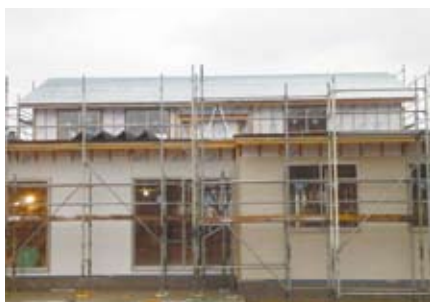
建設が進む小規模多機能型施設
