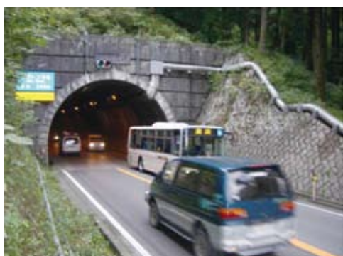
青葉トンネル
