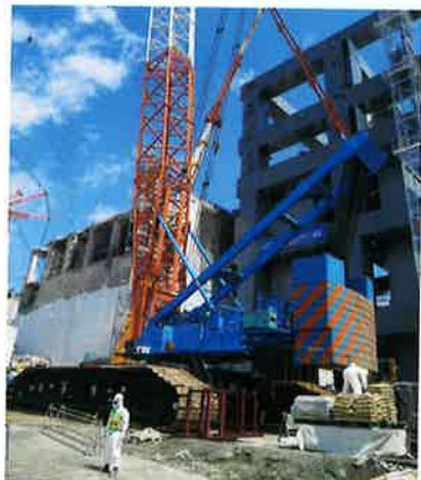
4号機の鉄骨構造物 (今後、燃料取出しクレーン等が設置される)
