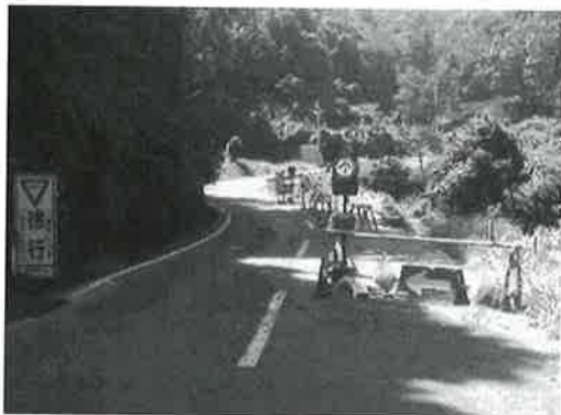
台風による被害で片側交互通行の道路
