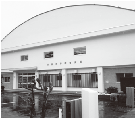
改修工事を終えた青郷小学校体育館
